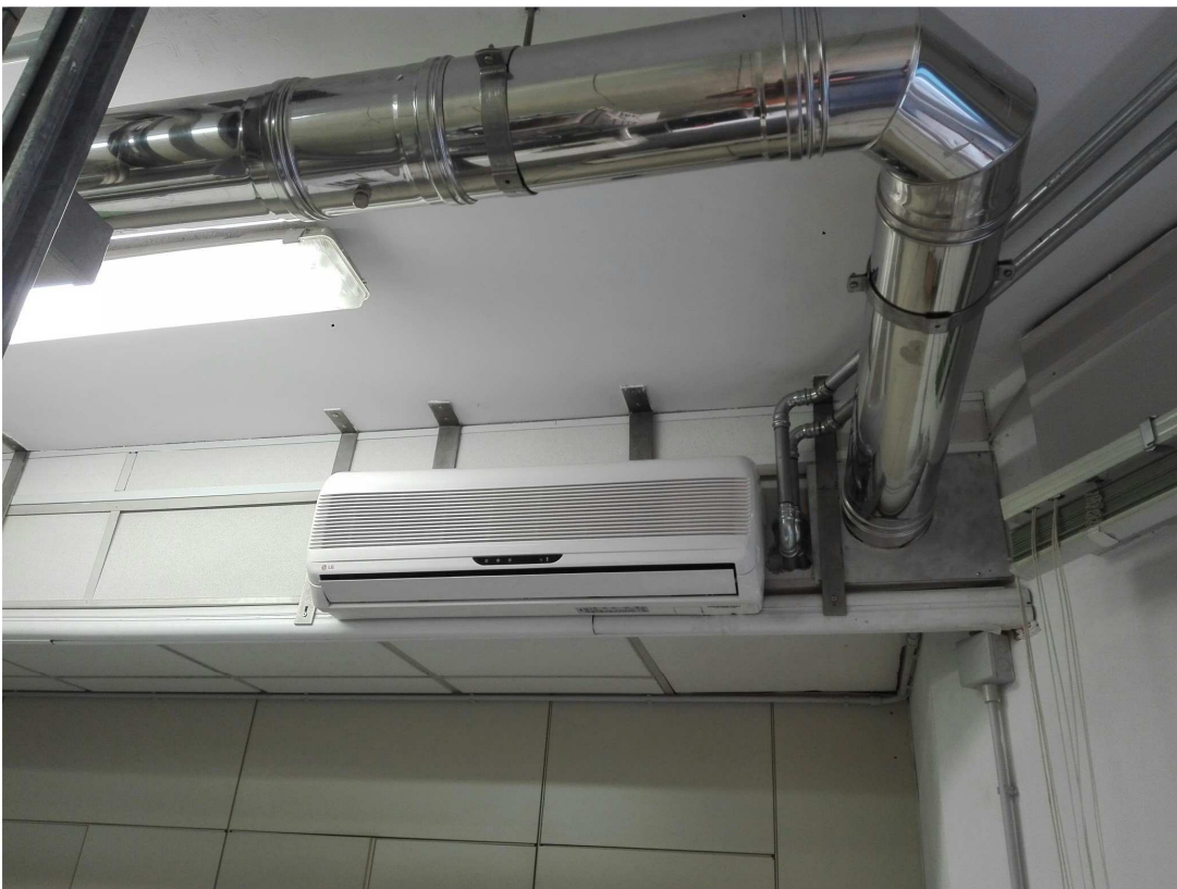
Unità Interne locale 7 (da cambiare)
