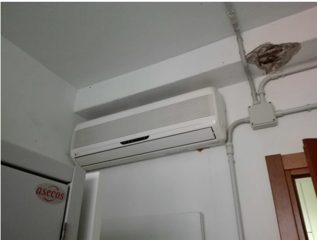
Unità Interne locale 9 (da cambiare)
