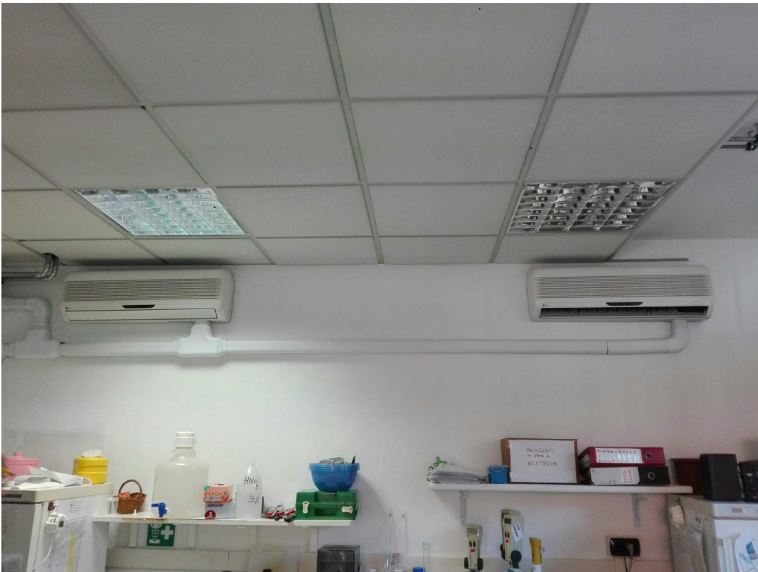
Unità Interne locale 10 (da cambiare)
