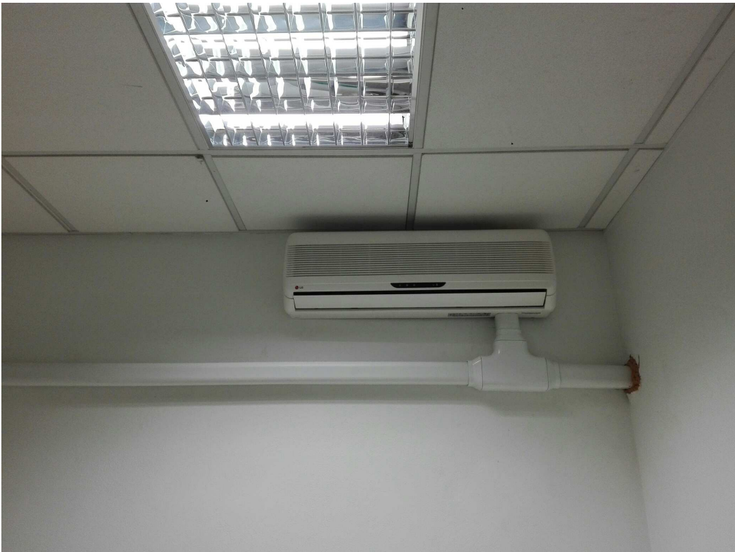
Unità Interne locale 8 (da cambiare)
