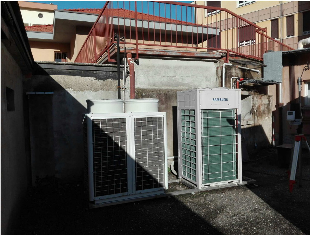
Unità Esterne (a sinistra quella da cambiare)
